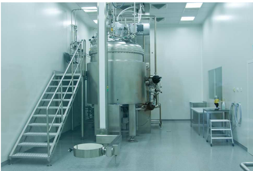
Anlage zum Ansetzen der Kollagen-Suspension.
